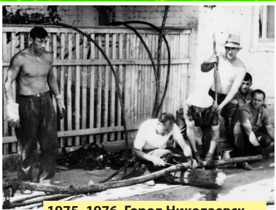
1975–1976. Город Николаевск. Прокладка кабельных линий по улице Чайковского
