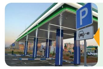
аждый комплекс включает два зарядных устройства мощностью 60 кВт каждое. Благодаря системе динамического распределения мощности одновременно могут заряжаться до 6 транспортных средств. Также в комплектации предусмотрено несколько типов коннекторов, чтобы подключиться могли различные марки электромобилей. Одним из преимуществ станций является наличие режима быстрого заряда. Полная зарядка современного электрокара займёт не более 1 часа.
